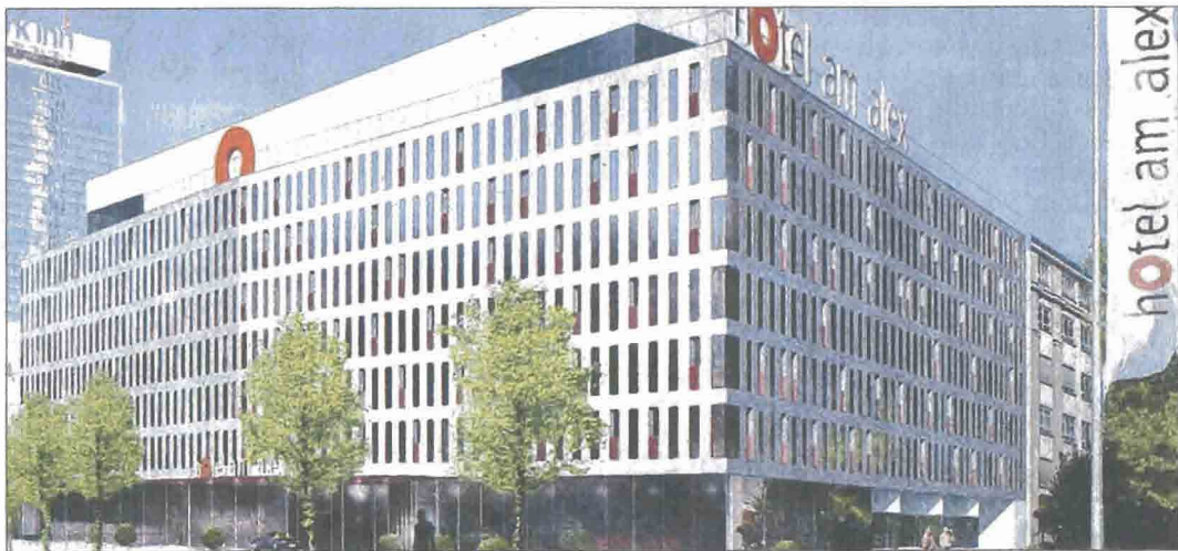
Nicht schön genug. Die Fassade des Hotels neben den Bahngleisen sorgt für Unmut. Foto: Hilpert AG
